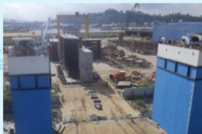
透過氣囊滾動移動沉箱組件到半潛駁船
