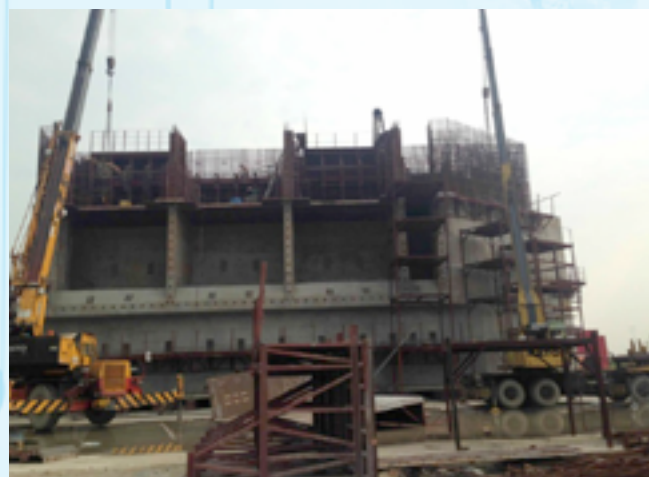
沉箱2F 製作進行中
