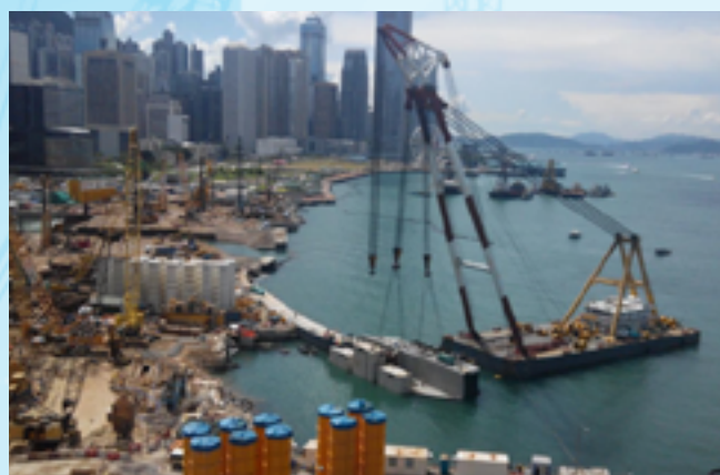
調整安裝沉箱組件位置
